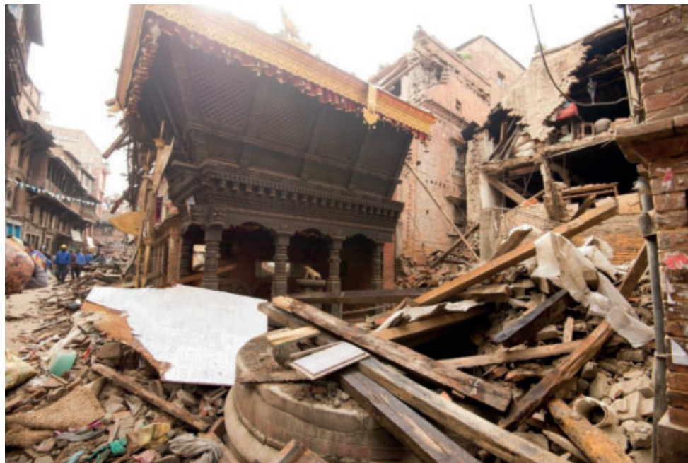
Изображение 1. Разрушения вследствие землетрясения магнитудой 7.8 баллов в Непале, 2015 год
